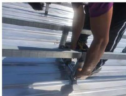
鐵皮屋頂支撐架結構設計示意圖
